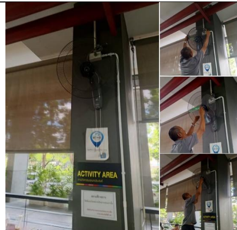
เปลี่ยนใบพัดลม ชั้น 1
