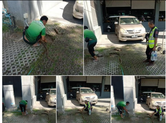
ซ่อมท่อน้ำประปาแตก
