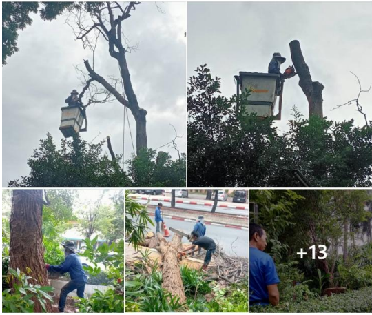
ดูแลกองภาพมาตัดต้นไม้ที่ตายแล้วที่ลานปูน
