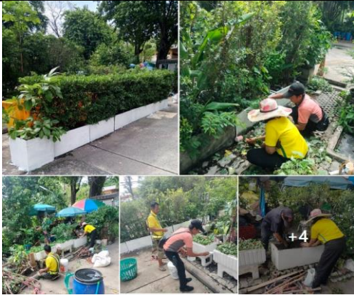
ปรับปรุงกระถางปูนเก่าและพื้นที่ซุ่ม รพ.ทางเข้าอาคาร
