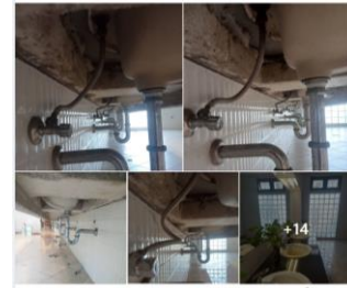
เปลี่ยนสายน้ำดี ห้องน้ำชั้น 2 ชั้น 10 ใหม่ทั้งหมด
