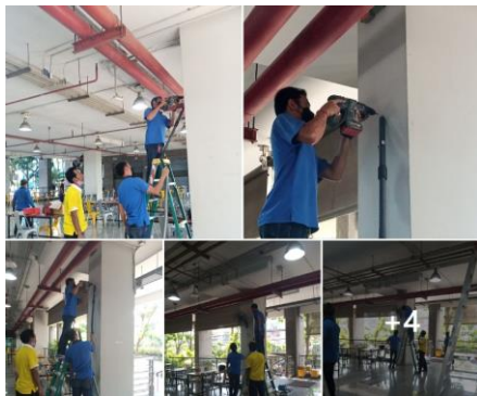
ดูแลบริษัท BSM ติดตั้งพัดลมโถงอเนกประสงค์ และในท้องน้ำชั้น 1
