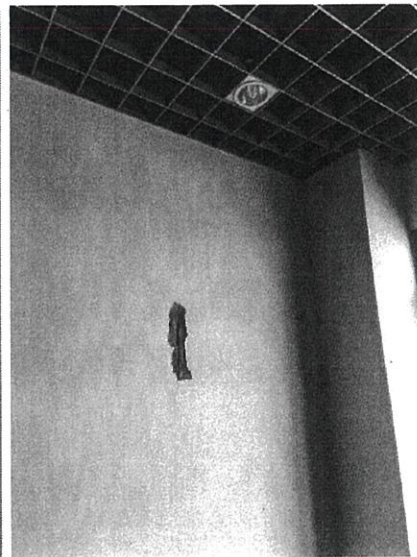
ภาพรอยร้าวบนกำแพงชั้น 9 ตำแหน่งใกล้ลิฟท์ 1-2 พบการกะเทาะของปูนจะเห็นเหล็กเสริมที่เป็นสนิม
