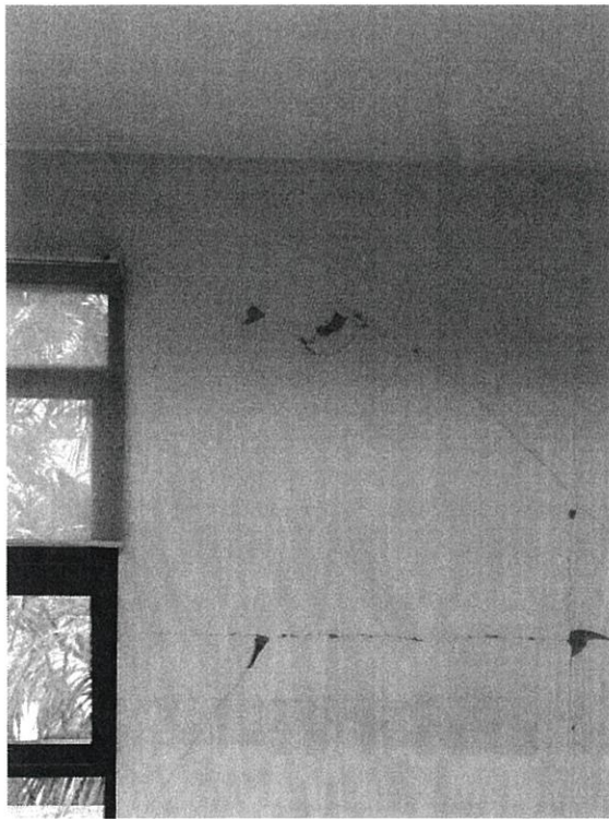
ตัวอย่างภาพรอยร้าวความเสียหายของกำแพงก่ออิฐที่เกิดจากผลของแผ่นดินไหว (สามารถซ่อมแซมได้ด้วยวิธีการซ่อมปกติ)
